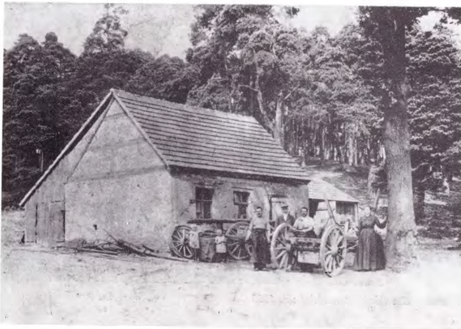
2 Die alte Dorischmiede an der Oranienburger Straße wurde 1832 gebaut
